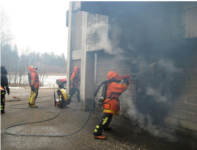
Fig 7.1 De COBRA wordt (bijna) altijd gecombineerd met de inzet van één of meerdere overdrukventilatoren. Een degelijke kennis van ventilatietechnieken is dus onontbeerlijk voor de COBRA gebruiker en zeker voor de COBRA instructeur. (Foto: Willem Nater)
