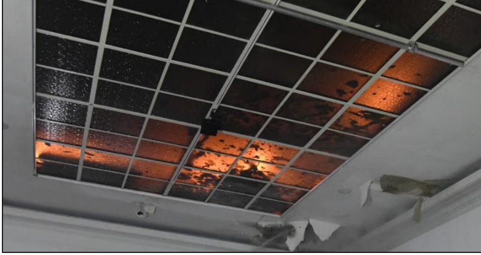
Şekil 7 Asma tavanın cam bölümünden bir görünüm. İçindeki yangın açıkça görülebiliyor. (Fotoğraf: Luc Van Ussel)
