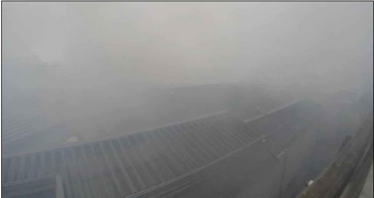
Imagem4 Vista do telhado após extinguir as chamas da estrutura construída. (Foto: Davy Platteau )
