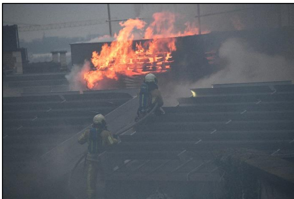
figure 8 Deux pompiers à l'œuvre près de l'une des structures en feu. (Photo : Robert Decock)
