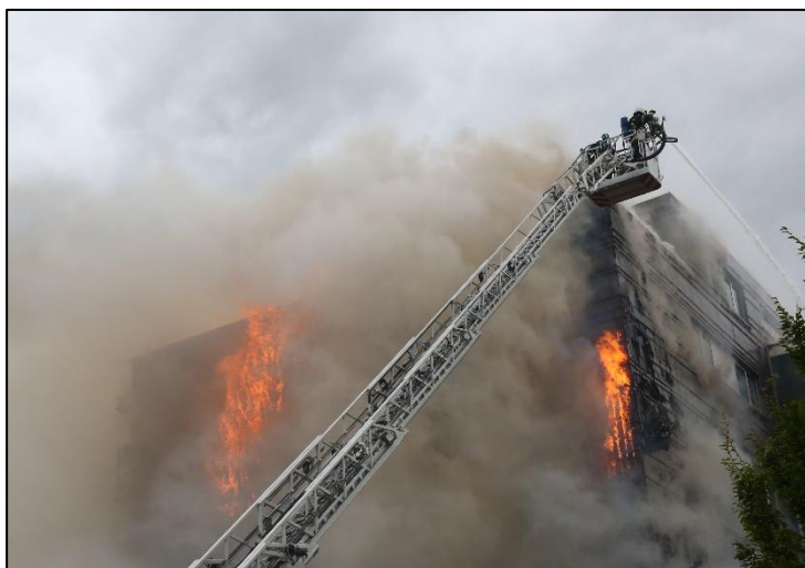
Figura 2 O incêndio de revestimento em Ypres. Nalguns locais, a fachada estava "aberta" podendo-se observar as chamas. Noutros locais, a fachada ainda estava "fechada" estando a ser produzido muito fumo. (Foto: Warre Saint-Germain)
