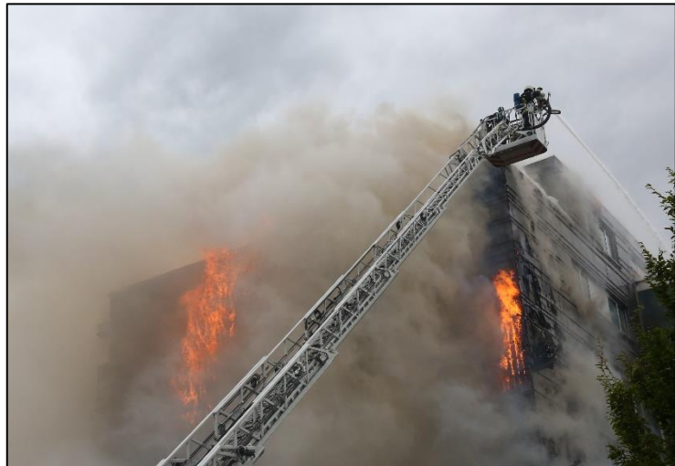
figuur 2 De gevelbrand in Ieper. Op sommige plaatsen is de gevel "open" en hebben de vlammen vrij spel. Op andere plaatsen is de gevel nog "dicht" en wordt vooral veel rook geproduceerd. (Foto: Warre Saint-Germain)
