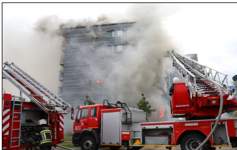
Figura 3 Durante l'incendio di Ypres, vi fu un enorme produzione fumo. Questa immagine mostra il rivestimento ancora principalmente intatto. Per questo motivo, poco è l'ossigeno che può raggiungere l'isolamento in fiamme. Questo porta ad un aumento della produzione di fumo. Il fumo viene spinto dalla facciata verso il tetto. In tali incendi è molto probabile che ci sia (un sacco) di fumo che si propaga nell'edificio stesso. (Picture: Warre Saint-Germain)
