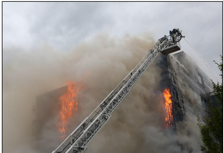
Figura 2 El fuego de revestimiento en Ypres. En algunos lugares, la fachada está "abierta" y se ven llamas. En otros lugares, la fachada todavía está "cerrada" y se está produciendo mucho humo. (Imagen: Warre Saint-Germain)
