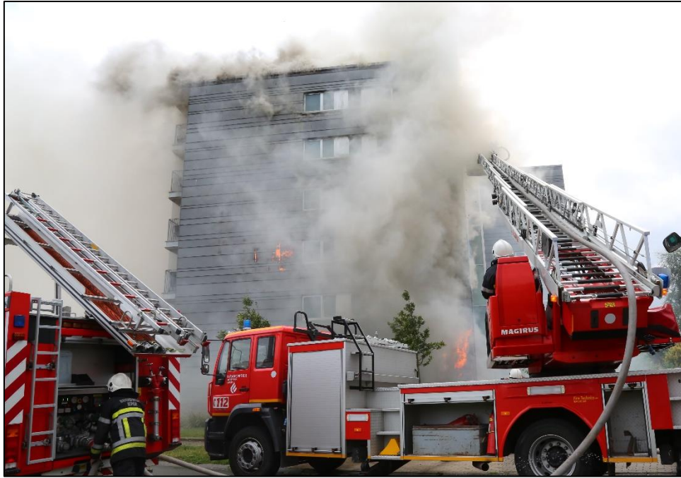
Figura 3 Durante el incendio de Ypres, se produjo mucho humo. Esta imagen muestra el revestimiento todavía intacto principalmente. Por esta razón, poco oxígeno puede alcanzar el aislamiento que está ardiendo. Esto a su vez conduce a una mayor producción de humo. El humo está siendo empujado desde la fachada en la conexión con el techo. Durante tal incendio, es muy probable que también haya mucho humo esparcido en el edificio mismo. (Imagen: Warre Saint-Germain)
