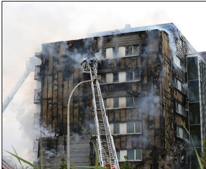
Figura 4 Al final del incendio en Ypres, queda poco combustible en la fachada. (Picture: Warre Saint-Germain)
