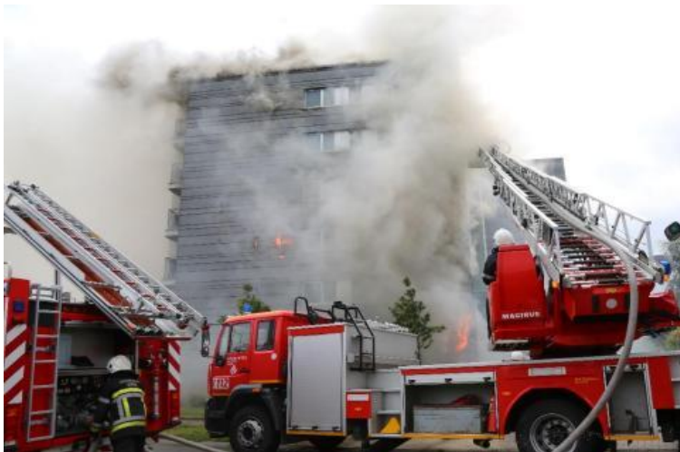
图 3 比利时伊普尔，火灾产生了大量的烟气。照片显示建筑外保温层基本完好无损。鉴于此只有很少的氧气能进入到燃烧区域，这也导致生成大量烟气，烟气被推到了建筑正面房顶的连接处。此类火灾发生时，（大量）烟气可能会蔓延至建筑内部。【图片：瓦雷圣日耳曼（Warre Saint-Germain）】
