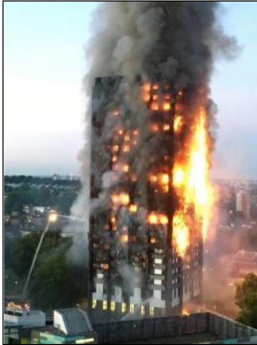
图1 起火点位于建筑四楼一公寓房，引燃了外保温层，随后火势从外部蔓延至建筑内部。
