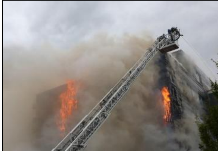
图2 比利时伊普尔的外墙保温层火灾。图中某些部位已被烧穿，所以可以看到火焰；另一些部位还没有，能看到浓烟冒出【图：瓦雷圣日耳曼（Warre Saint-Germain）】
