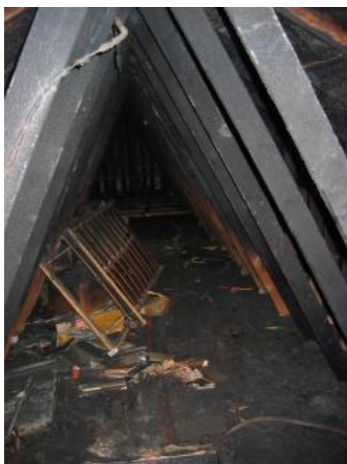
图2 站在梯子上看到的阁楼情况，这张照片显示了阁楼的狭窄程度。（来源：Westhoek消防局-迪克斯穆德消防站）
