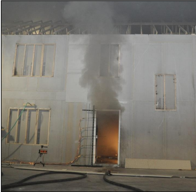
Bild 4 Die Rauchgase strömen aus dem oberen Teil der Türöffnung aus, während der Rest der Öffnung zur Frischluftzufuhr genutzt wird. Die frische Luft wird für eine schnelle Brandausbreitung sorgen. (Foto: Steve Kerber – Underwriters Laboratories)
