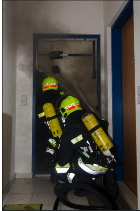
图2 阻烟器肯定会影响到内攻进门程序的实施，在使用时必须考虑到这一点。（拍摄：Lukas Derkits）
