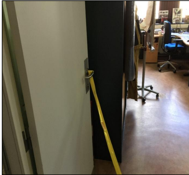
图 6 拿水带的消防员通过使用扁带可以在门完全打开的情况下保持对门的控制。（拍摄：Karel Lambert）
