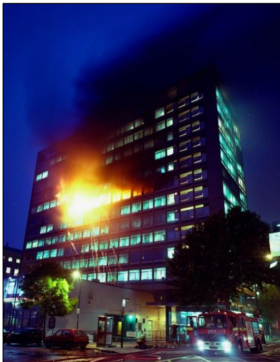
Figura 2 a maioria das janelas tinham colapsado e as chamas que saem do edifício são um risco para os pisos superiores. (Foto: London evening news)
