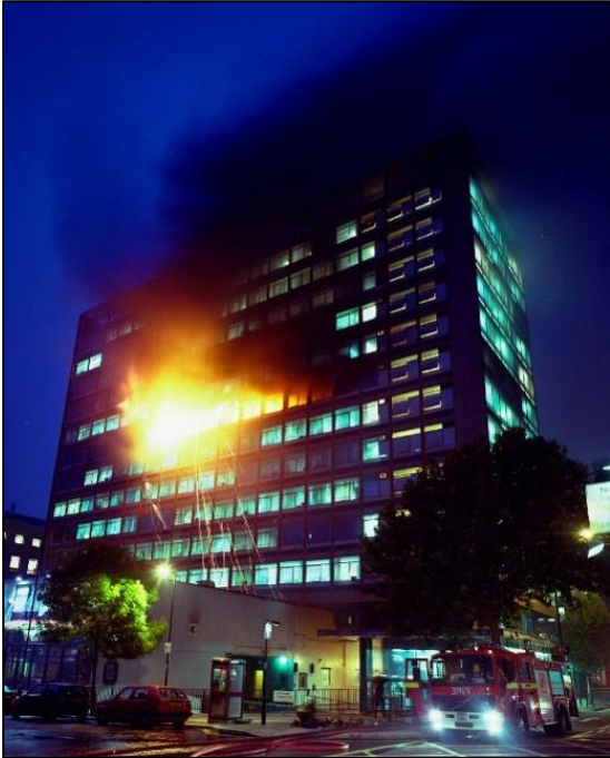
figuur 2 De meeste ramen zijn eruit en de uitslaande vlammen zijn een bedreiging voor de bovenliggende verdieping. (Foto: London evening news)
