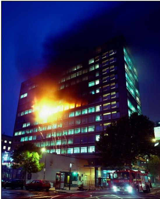
Figura 2 La maggior parte delle finestre è crollata e le fiamme che escono dall'edificio sono una minaccia per il piano superiore. (Photo: London evening news)
