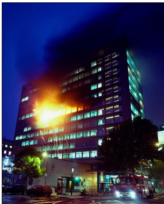
Image 2 La plupart des fenêtres se sont brisées et les flammes sortant du bâtiment sont une menace pour l'étage au-dessus. (Photo: London evening news)
