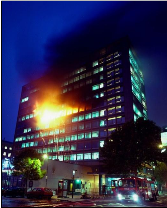
Figura2 La mayoría de ventanas han colapsado y las llamas que salen del edificio son un riesgo para los pisos superiores. (Photo: London evening news)
