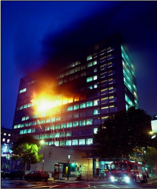
图2 大部分窗户已经破碎，楼内喷出的火焰对楼上构成威胁。(图片：伦敦晚间新闻)
