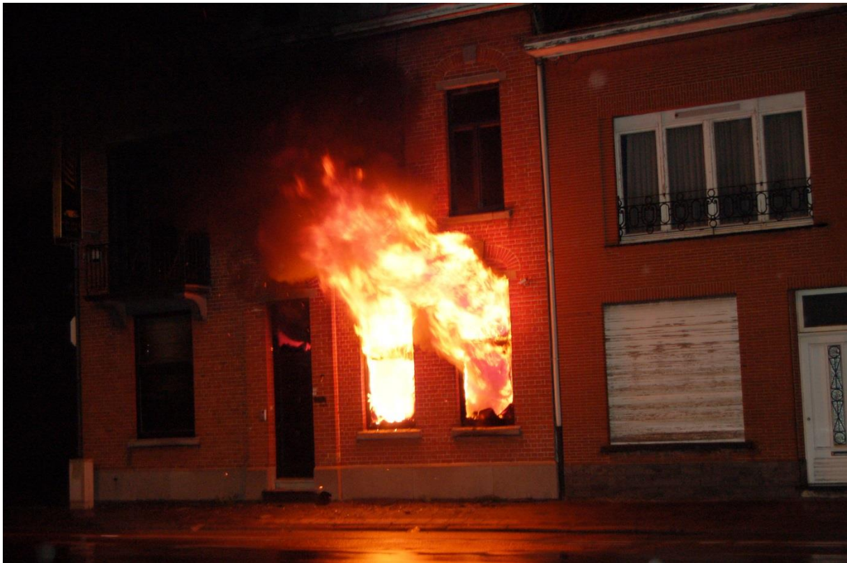
Figura 3 Incêndio totalmente desenvolvido no rés do chão da casa. (Foto: Nico Speleers)
