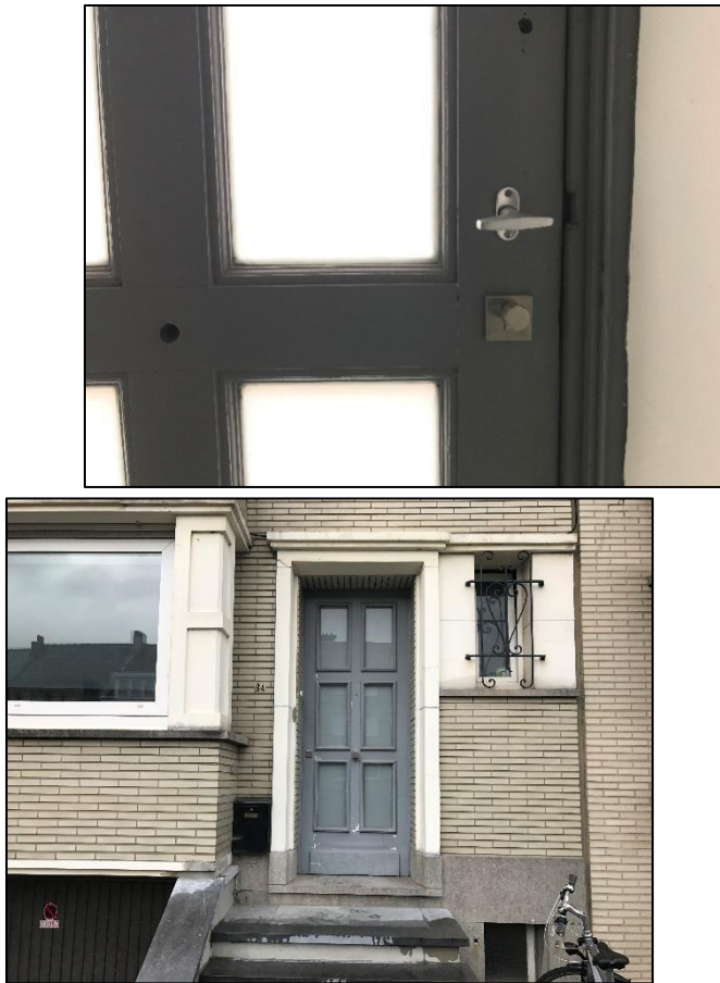
图 10 图 11 这种带窗的前门，打破玻璃比用哈里根简单得多。当然门外的消防员不是很清楚锁的样子(来自: Christophe De Cock)
