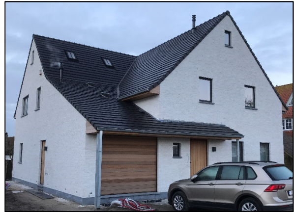
Şekil 7 Aynı evin bitmiş hali. Dış cephe kaplaması olarak tuğla kullanılmış. Ev tıpkı geleneksel yöntemle yapılmış bir ev gibi görünmektedir. (Fotoğraf: Nathalie Van Moorter)
