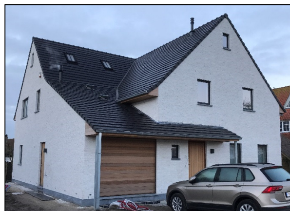
Figuur 7 Het afgewerkte huis. Er is gekozen voor een baksteen als gevelbekleding. Het huis ziet eruit als een traditionele woning. (Foto: Nathalie Van Moorter)
