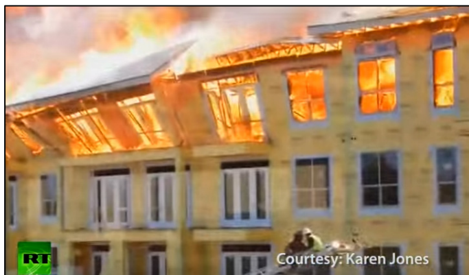
Figuur 4 en Figuur 5 Twee foto's tonen de evolutie van een brand in een houten appartementsgebouw (© Beelden: Karen Jones)
