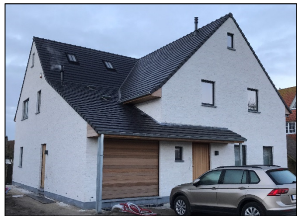
Figura 7 La stessa casa una volta terminata. Il mattone è stato scelto come uno strato esterno di finitura. La casa ha lo stesso aspetto di un edificio tradizionale. (Photo: Nathalie Van Moorter)
