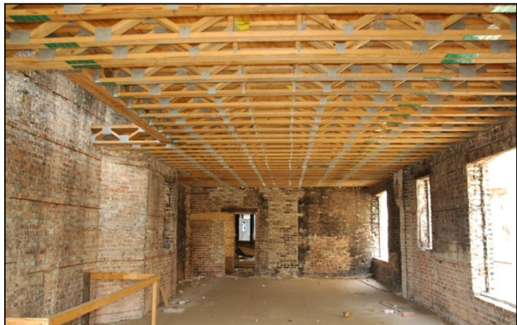
Figura 1 solaio a travetti tralicciati (Photo: NIST)
