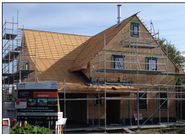
Image 6 Construction d'une maison en bois. (Photo: Nathalie Van Moorter)
