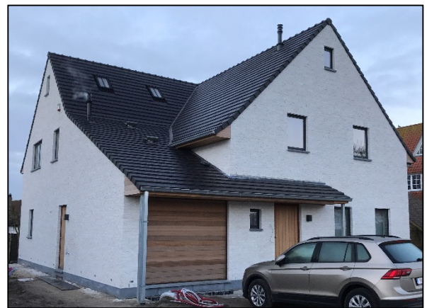
Figura 7 La misma casa una vez terminada. El ladrillo se ha elegido como acabo exterior. La casa parece igual que una construcción tradicional. (Photo: Nathalie Van Moorter)
