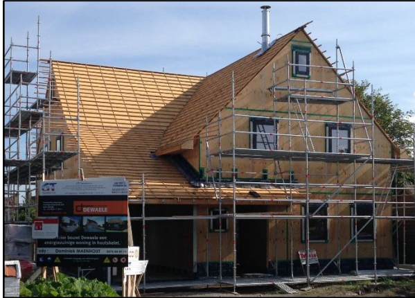
Bild 6 Der Bau eines Holzhauses. (Foto: Nathalie Van Moorter)
