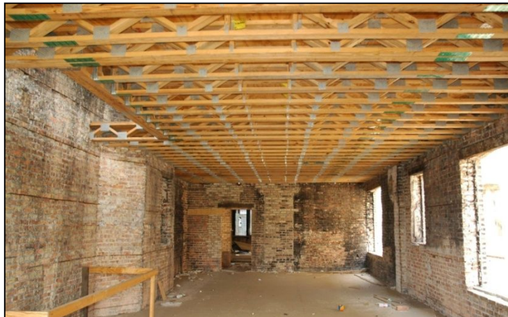
Bild 1 Hölzerne Fachwerkträger (Photo: NIST)
