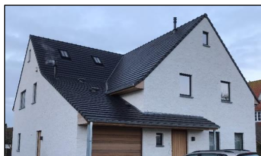
图 7 —栋房子在施工后,因为建筑物外部被砖块覆盖所以看起来跟传统房屋没有区别 拍摄: Nathalie Van Moorter
