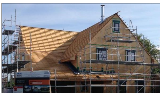
图 6 —栋正在建造的木结构房屋 拍摄: Nathalie Van Moorter
