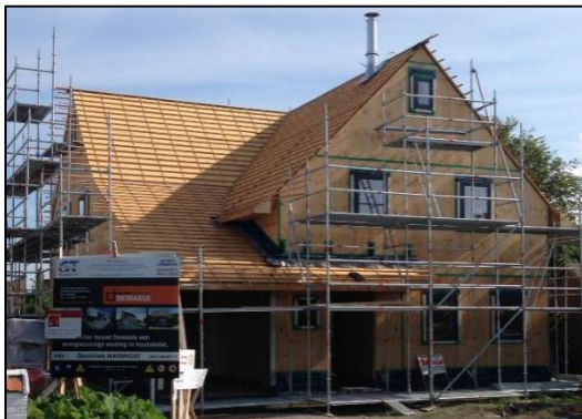
图 6 一栋正在建造的木结构房屋 拍摄: Nathalie Van Moorster
