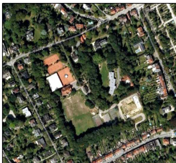
图 2 火灾发生后拍摄的俯视图。上方是 Dieweg 路，下方是 St-Job's 路。图右下方可以清楚地看见建筑物前方的回形弯道。(图片来源：谷歌地图)
