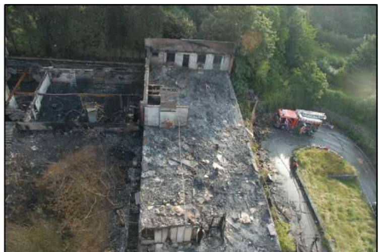
图 10 火灾发生后拍摄的建筑 B 和 C 的俯视图。两个建筑的钢筋混凝土结构均未受到影响。上方的木质结构已经完全被烧塌了。建筑 B 的矩形外墙支撑房顶桁架的痕迹。这就意味着房顶与吊顶之间还有一定的空间。图中还可看到建筑后的树木和围墙，鉴于此，无法进行全方位的火情侦察。(图片来源: Robert Decock)
