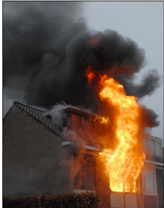
Figura 4 Incêndio totalmente desenvolvido ventilado a partir da parte traseira do edifício. (Foto: nufoto.nl)
