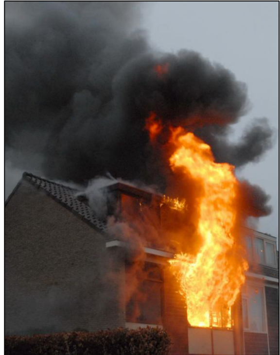
Figura 5 Incendio generalizzato che sfoga sul retro di un edificio. (Photo: nufoto.nl)
