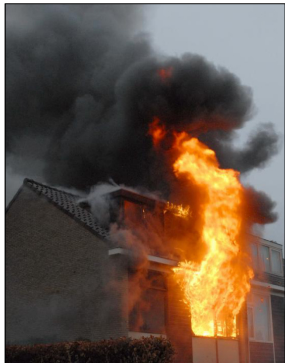
Image 5 Feu pleinement développé sortant par l'arrière d'un bâtiment. (Photo: nufoto.nl)
