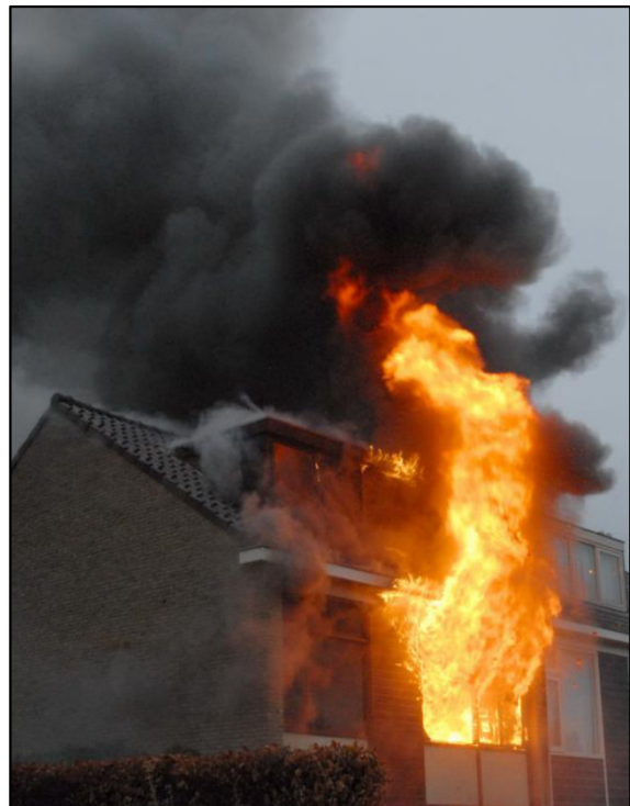
Figura 4 Incendio totalmente desarrollado ventilado desde la parte trasera del edificio. (Photo: nufoto.nl)
