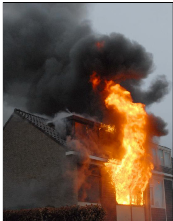
Bild 4 Flammenauschlag an der Hinterseite eines Gebäudes (Foto: nufoto.nl)
