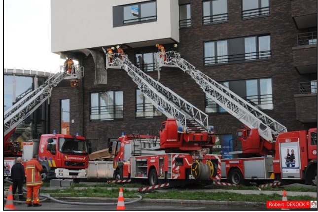
Şekil 8 Üç merdivenli araç sıva ve EPS yalıtımını temizlemek için çalışıyor. (Fotoğraf: Robert Dekock)
