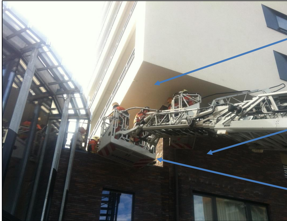
Şekil 4 Resmin solunda Schaarbeek istasyonunun merdiven ekibi çalışıyor. Birkaç itfaiyeci düz çatıda. Yangının başladığı yer, çatı ile konsol bölümü arasındaki tuğla duvar. Altındaki mavi okla gösterilen duvar bölümü yaklaşık 2 metre genişliğinde. Yangının köşeyi geçerek tuğla duvarın tamamına yayılma ihtimali vardır. (Fotoğraf: Pieter Maes)
