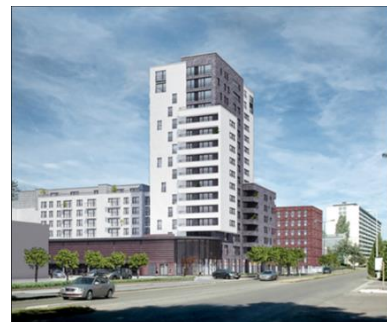
图1 建筑插图。墙体上白色的窗格是外抹灰层，而较暗的部分是砖。在左前方，可以看到边楼。图片由A2RC绘制。
