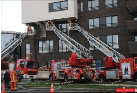
图9 三辆云梯车正在清理外抹灰层和 EPS 隔热保温层。照片由 Robert Dekock 提供。
