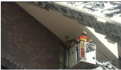
图 7 消防员沿墙体移动了 5 米，用救援链锯再次进行切割。照片由 Pieter Maes 提供。
