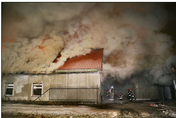
Figure 7 Durante questo incendio non ventilato, la temperatura interna è molto elevata. La sovrappressione interna spingerà il fumo all'esterno. (© Photo: Zbigniew Wozniak)
