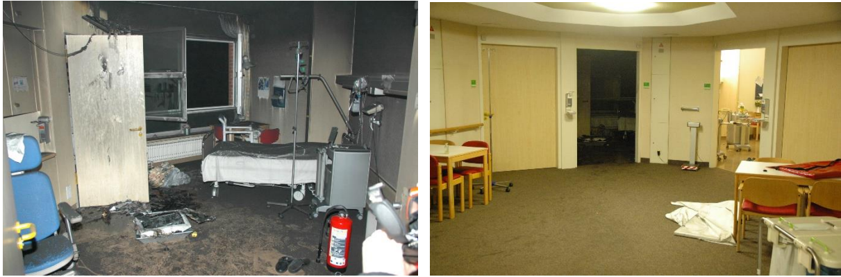
Şekil 9 Almanya'da bir hastane odasında çıkan yangın. Soldaki resim hastane odasının tamamen dumanla dolu olduğunu göstermektedir. Sağdaki resim koridoru göstermektedir. Resmin ortasında yangın odasına açılan kapı görülüyor. Koridorda hiç duman hasarı yok. Duman durdurucu resmin sağ ucunda yerde duruyor. (Fotoğraf: Michael Reick)
