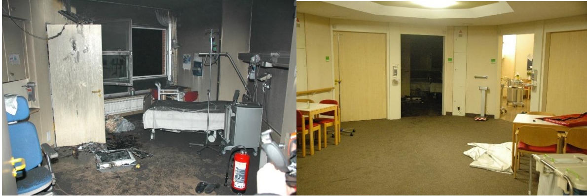
Figura 9 Incêndio num hospital na Alemanha. A imagem à esquerda mostra que o quarto do hospital estava completamente cheio de fumo. O da direita mostra o corredor. No meio da figura há uma porta que comunica com o compartimento do incêndio. Não há danos causados pelo fumo no corredor. A cortina bloqueadora está no chão na parte inferior da direita. (Foto: Michael Reick)
