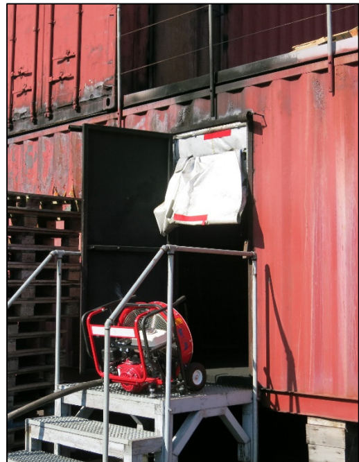
Figuur 6 De rookstopper sluit de bovenzijde van de deuropening af. Hierdoor wordt de uitstroom bovenaan beperkt. De ventilator kan dan dichterbij geplaatst worden. (Foto: Michael Reick)
