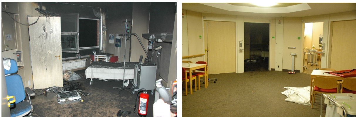
Figura 9 Incendio in una stanza d'ospedale in Germania. L'immagine a sinistra mostra che la stanza d'ospedale era completamente invasa fumo. L'immagine a destra mostra il corridoio. Al centro dell'immagine vi è la porta che conduce nella stanza dell'incendio. Non vi è alcun danno da fumo nel corridoio. Lo smoke stopper è appoggiato a terra nell'estremità destra dell'immagine. (Photo: Michael Reick)
