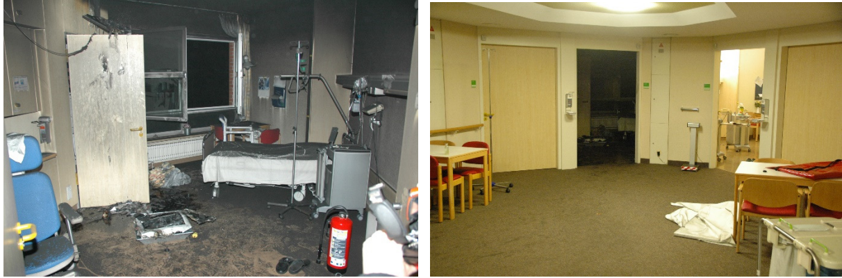
Figure 9 Incendie dans une chambre d'hôpital en Allemagne. L'image de gauche montre que la chambre a complètement été remplie de fumées. L'image de droite montre le couloir, au milieu se trouve la porte accédant à la chambre sinistrée. Il n'y a pas de dommages dans le couloir. Le stoppeur de fumées est sur le sol à l'extrémité droite de l'image. (Photo: Michael Reick)
