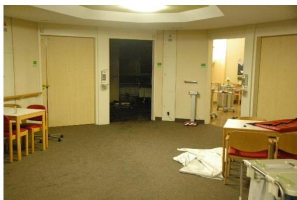
图7 德国一家医院发生火灾。左图显示房间内曾充满烟气。右图是走廊拍，中间是起火房间，走廊没受到烟气损害，阻烟器放在图片右侧的地板上。（照片：迈克尔·赖克）
