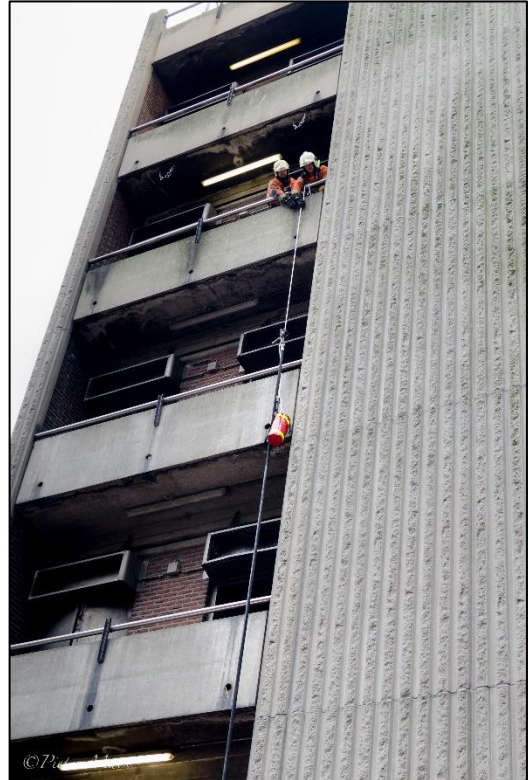
Şekil 2 Halat kullanarak bir yüksek basınçlı hortumu yukarı çekme. (Fotoğraf: Pieter Maes)
