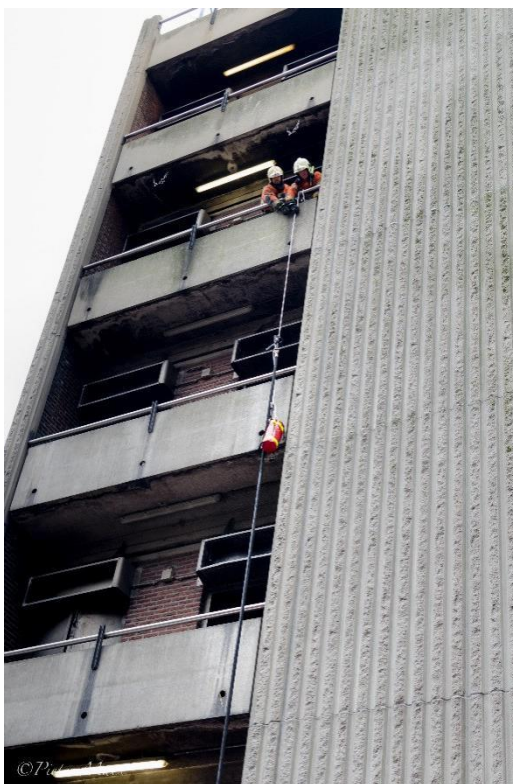
图 2 使用绳索拉起高压软管。【照片：彼得·梅斯 (Pieter Maes)】
