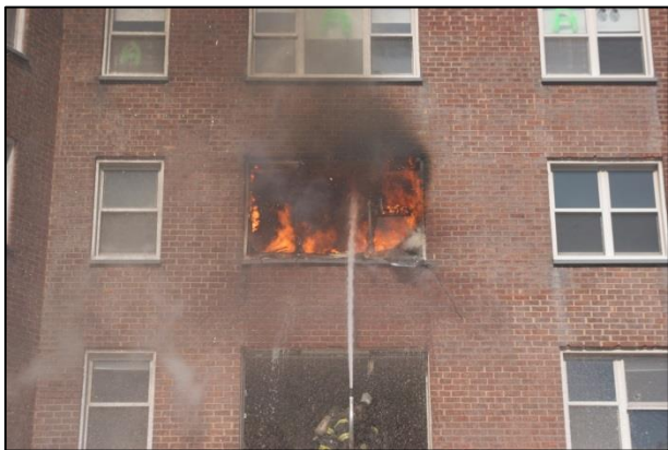
Figura 5 Utilização da agulheta a partir do piso abaixo para que flua água para dentro do compartimento incendiado sob condições dominadas pelo vento. (Foto: NIST)
