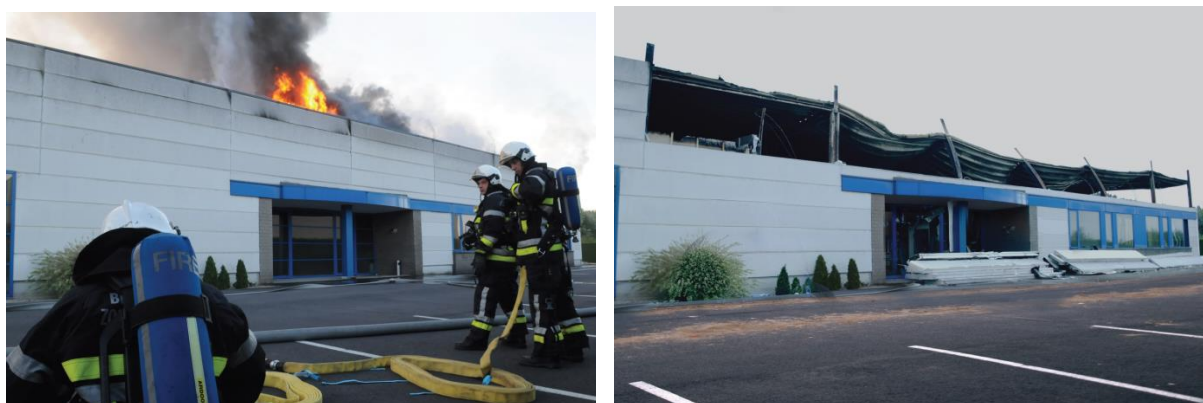
Figura 4 Um incêndio num edifício industrial composto por painéis de parede pré-fabricados. Devido ao risco de colapso, devem ser mantidas as devidas distâncias de segurança às paredes. De seguida, todos os painéis soltos são removidos para eliminar qualquer risco de colapso. (Fotos: Peter Vangierdegom)
