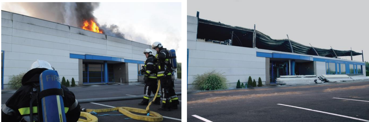
Figure 4 Un incendio in un edificio industriale costituito da pannelli prefabbricati. A causa del rischio di crollo, viene mantenuta la distanza dal muro. Successivamente, eventuali pannelli sciolti vengono rimossi per eliminare ogni rischio di collasso. (Photo's: Peter Vangierdegom)
