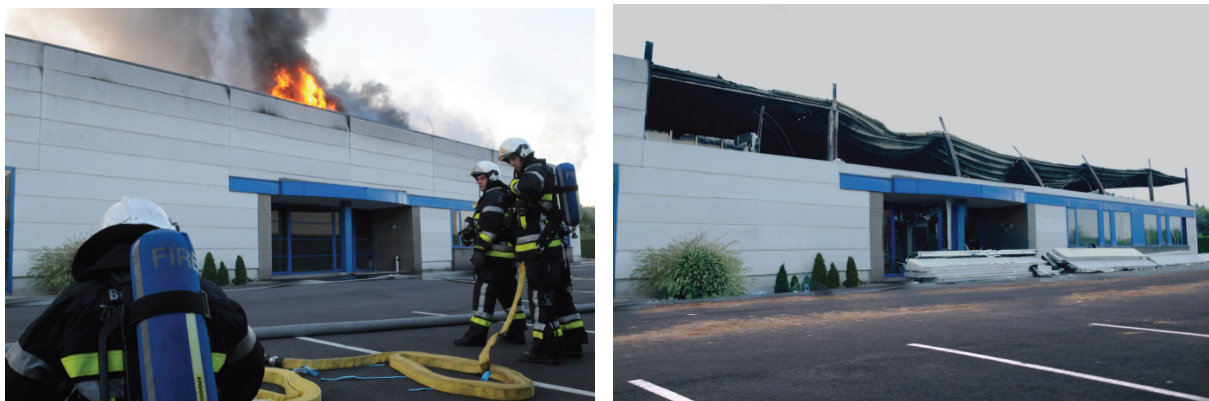
Figure 4 Un incendie dans un bâtiment industriel composée de panneaux préfabriqués. En raison du risque d'effondrement, la distance à la paroi est maintenue. Ensuite, tous les panneaux lâches sont retirés pour éliminer le risque d'effondrement. (Photo's: Peter Vangierdegom)
