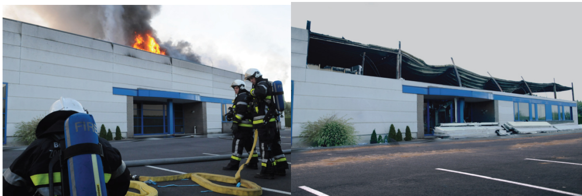
Figura 4 Un incendio en un edificio industrial hecho de paredes de paneles prefabricados. Debido al riesgo de colapso, se mantenía la distancia a la pared. Después de todo, ningún panel sujeto era eliminado para suprimir cualquier riesgo de colapso. (Photo's: Peter Vangierdegom)
